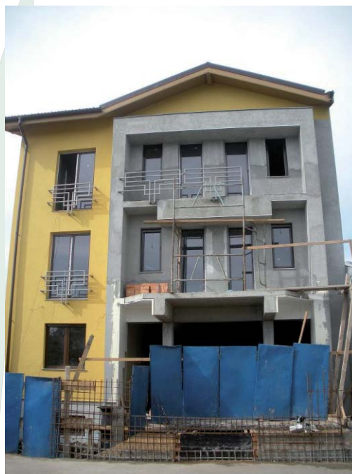
... la Casa in corso di approntamento ...
