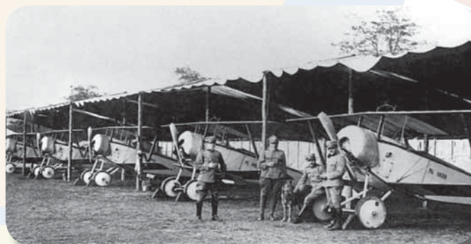
Alcuni Piloti con i loro Nieuport-Macchi 11 ospitati in rimesse di fortuna
