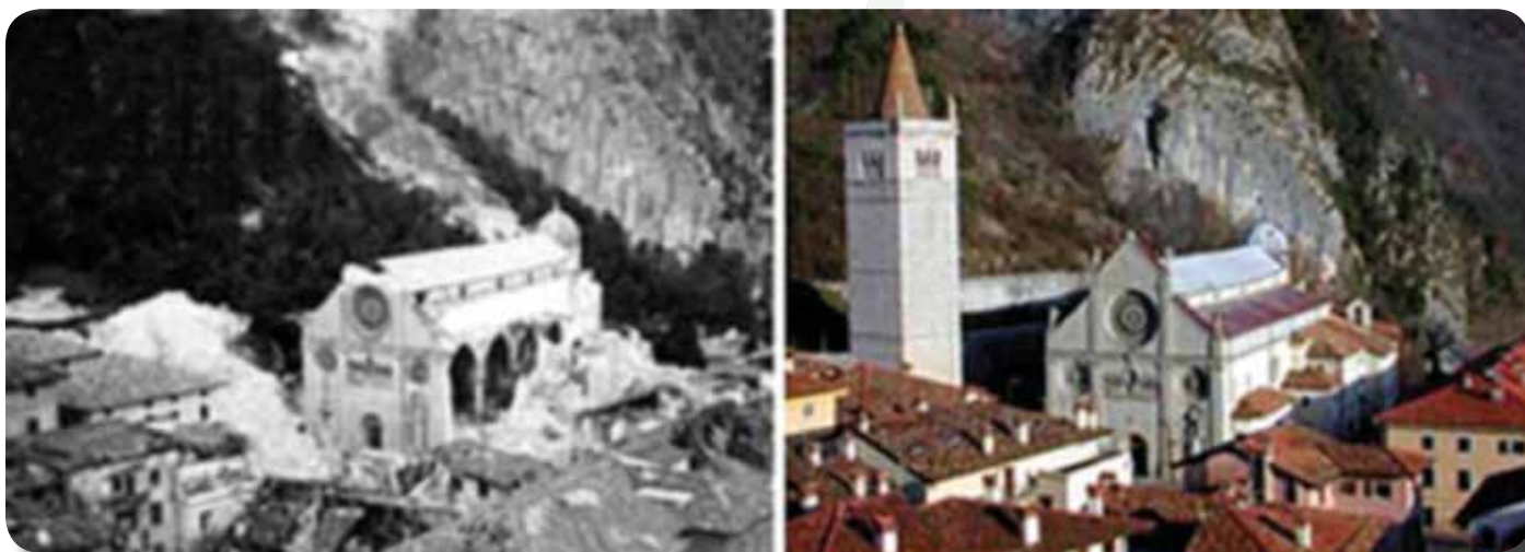
Macerie del campanile e del Duomo di Gemona nel 1976 e dopo la completa ricostruzione
