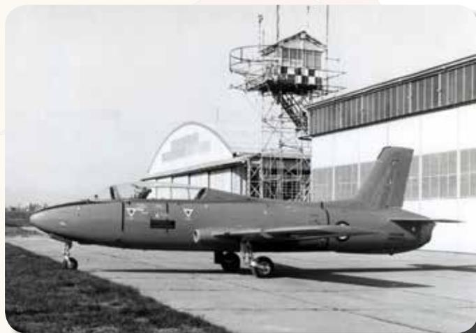
L'industria varesina proponeva un piccolo jet in configurazione biposto in tandem, da destinare ai primi due periodi di istruzione al volo, quello iniziale e quello basilico.
