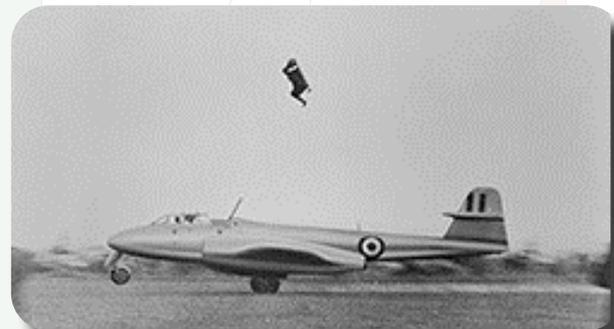
1955 - Primo test di espulsione dalla pista dal vivo Sqn Ldr JS Fifield
